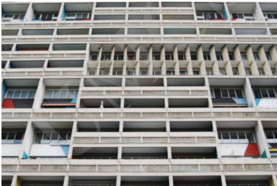
Ilustracja 11. Relief elewacji Jednostki Berlińskiej, fot. A. Pilip (2010).
